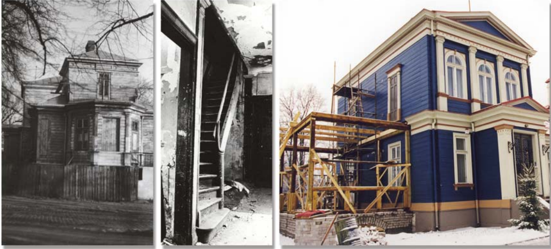
Centrālā mikrofotokopēšanas un dokumentu restaurācijas laboratorijas ēka pirms atjaunošanas un fasādes remonta restaurācijas laikā, 1980.–1997. gads
